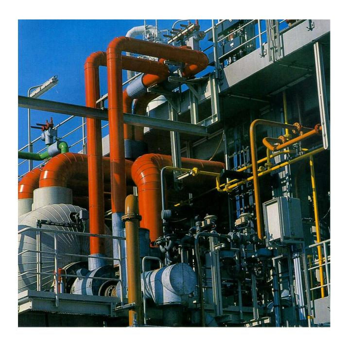
Das Bild zeigt einen Teil der Chlorwasserstoff-Rückführung bei der Silicon-Herstellung bei WACKER im Werk Burghausen.
